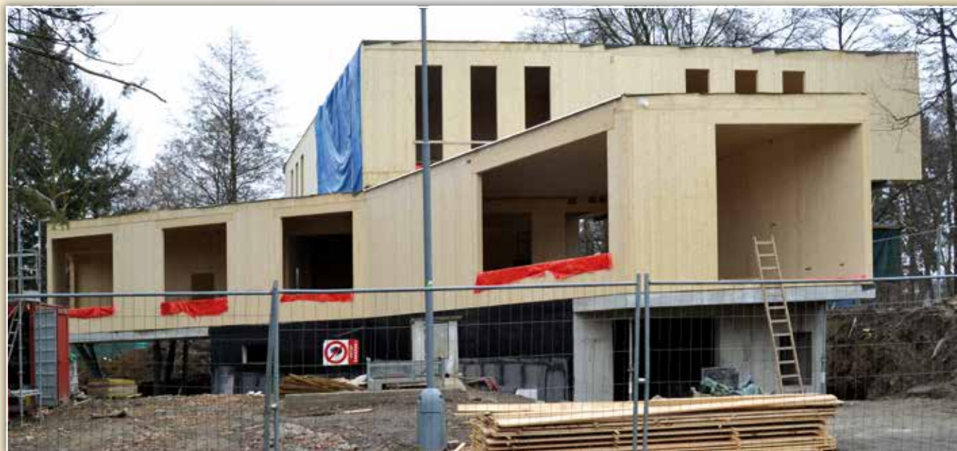
Vznikající dřevostavba návštěvnického centra je zajímavým oživením architektury města.
