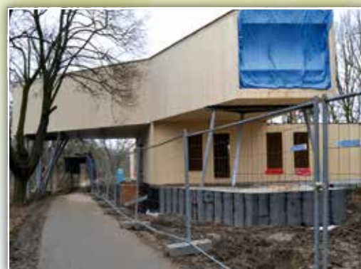
Pohled z cyklostezky od sokolovny na rozestavěnou budovu.
